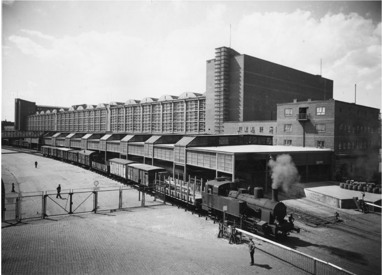
Blick von Südosten auf die Frankfurter Großmarkthalle in den 1930 Jahren, Institut für Stadtgeschichte Frankfurt am Main, S78 1998/14.158.
